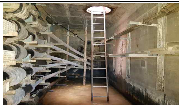
내용 맨홀 내부 전경
