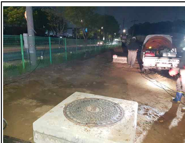
내용 맨홀 외부 전경 상태양호
